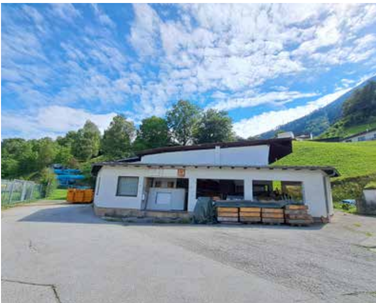
Am Areal der alten Liftstation hinter dem Schwimmbad werden neue Wohnungen gebaut.
