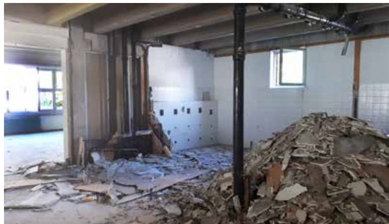
Bereits kurz nach Schulschluss wurde Mitte Juni mit den Abbrucharbeiten begonnen. Vor allem die Sanitäranlagen waren nicht mehr zeitgemäß.
