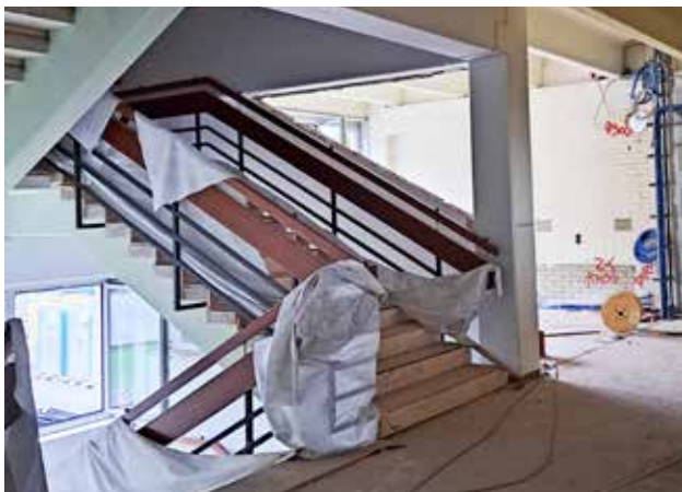
Das Stiegenhaus ist ebenfalls in die Jahre gekommen. Durch das Abtragen mehrerer Wände kommt nun mehr Licht in diesen Teil des Gebäudes.
