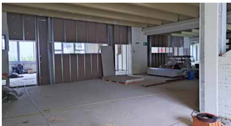
Die großzügige Bauweise der Schule und die „Aula-Atmosphäre“ wird in Zukunft für offenen Unterricht genutzt. Dabei helfen Fenster, die das Licht von außen über die Klassenräume hinweg in das Foyer abgeben.
