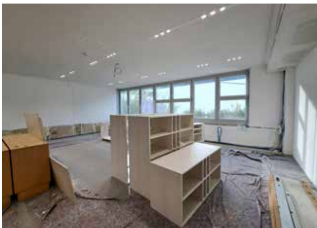
Ende August ist das Ziel bereits deutlich sichtbar: hellere Klassenräume und vor allem viel Platz für optimales Lernen.
